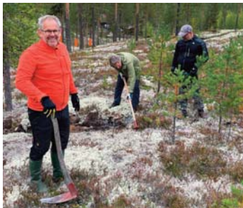
Tufft att få ner jordkabeln mellan all sten.
