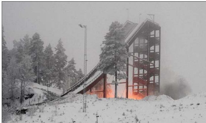
Hoppbackarna på Mickeltemplet. Bilden ovan - sprängningen
